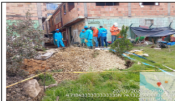
Fotografía No. 9: Intervención operativa en curso, motobomba y mangueras azules de captación de agua residual en zanja. Registro del 20/03/2026. Imagen suministrada por SDA.
