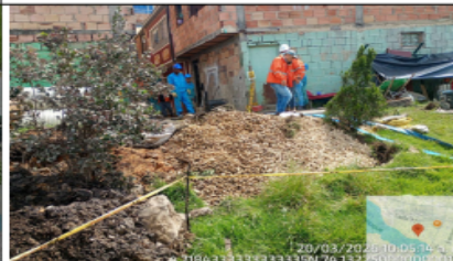
Fotografía No. 8: Intervención operativa en curso dentro de la Reserva Distrital de Humedal Jaboque. Registro del 20/03/2026. Imagen suministrada por SDA.
