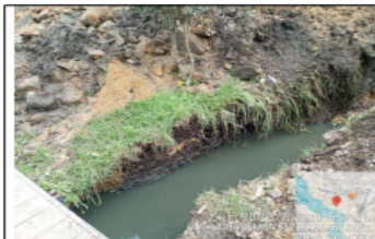
Fotografía No. 5: Apertura de zanja y ingreso de vertimientos de aguas residuales al RDH. Registro del 20/03/2026. Imagen suministrada por SDA.
