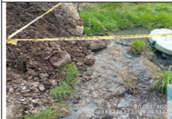
Fotografía No. 7: Vertimiento de agua residual RDH Registro del 20/03/2026. Imagen suministrada por SDA.
